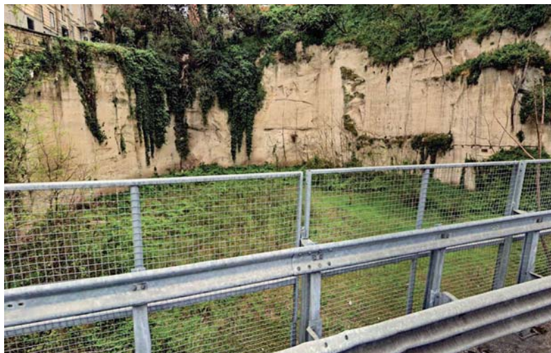
L'area della ex cava di tufo vista dalla tangenziale, dopo la demolizione dell'edificio. Immagine ricevuta da Luigi De Falco. In basso, il momento della consegna del Premio con Aldo De Chiara e Mariarita Signorini
